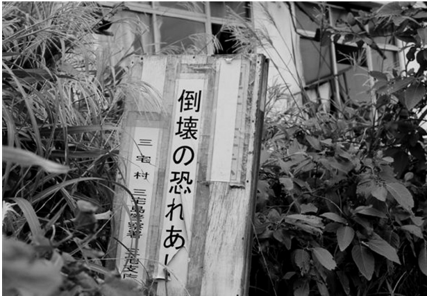
家主が放置、三池の危険建造物(10月19日撮影)
