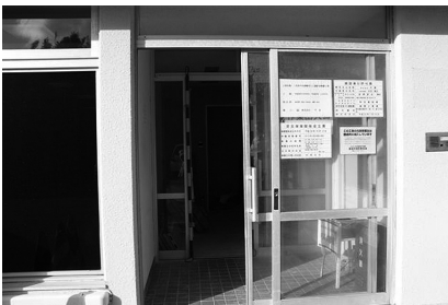
来春の開設を待つ工事中の診療所
