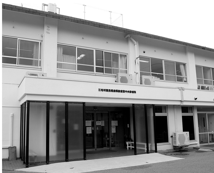
人工透析機が設置されていない中央診療所
