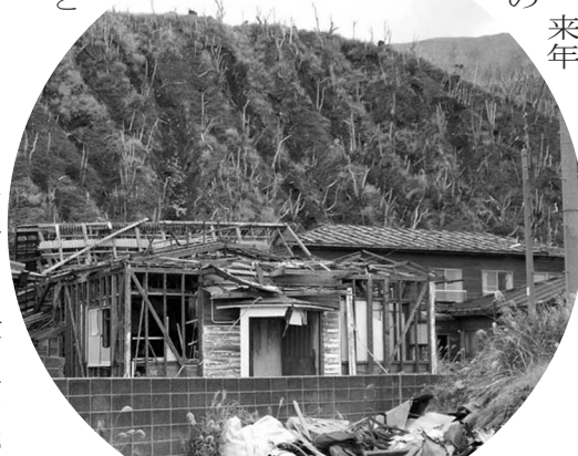
崖崩れが頻発する三池高濃度地区
